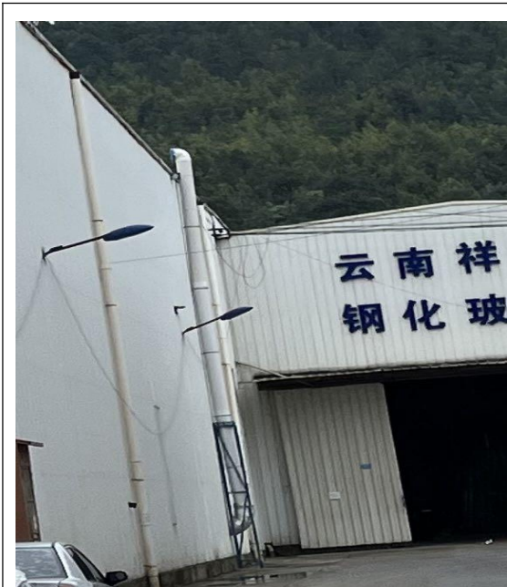
夹胶废气排气筒
